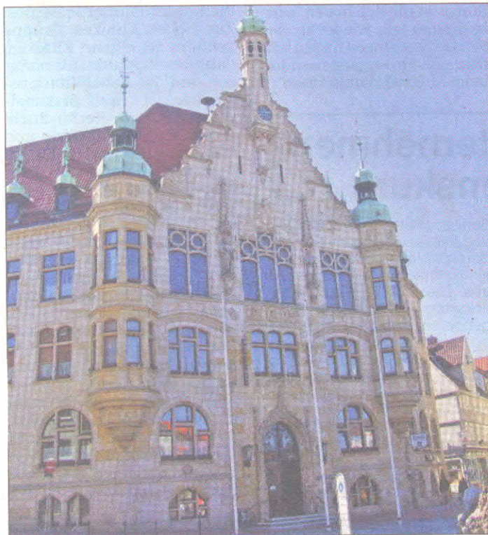
Auch das Rathaus gehört zu den am meisten Energie verbrauchenden Gebäuden im Besitz der Stadt Helmstedt.
