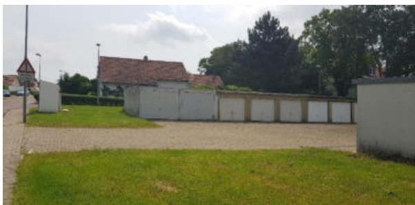
Abbildung 27: Sanierungsbedürftige Garagenflächen Wilhelm-Busch-Str.
