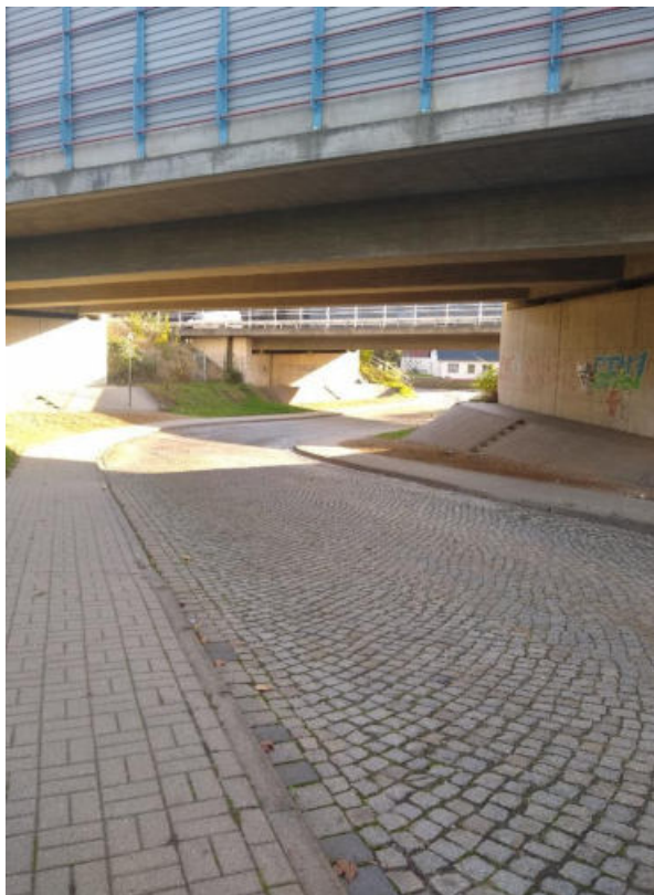
Abbildung 52: Autobahnunterführung Am Botschenberg
