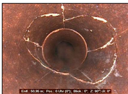
Abb.: Kanalkamerabild einer defekten Leitung (Scherbenbildung)
