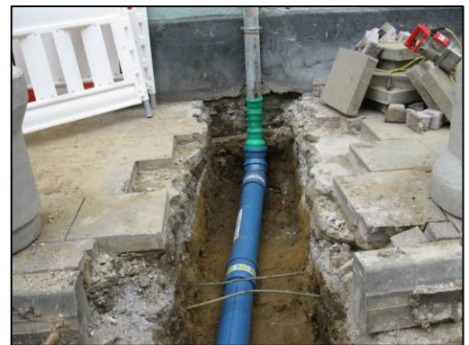
rechts: Erneuerung einer Regenwasserleitung in offener Bauweise
