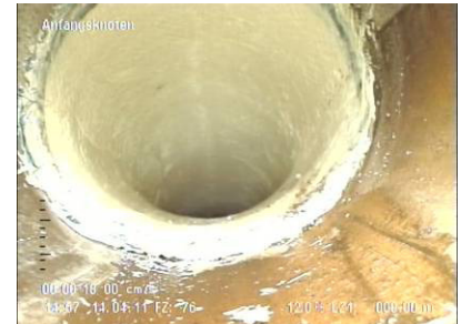
Abb.: verklebter Kurzliner in einem Abwasserrohr
