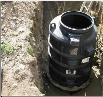
Abb.: Nachrüstung mit einem Kunststoffschacht
