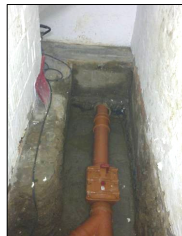
Abb.: eine erneuerte Abwasserleitung im Kellergeschoss
