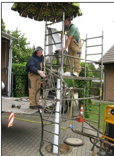
Abb.: Einbau eines Schlauchliners mit größerem Durchmesser (Anlagen für den Gebrauch innerhalb eines Gebäudes sind entsprechend kleiner)
