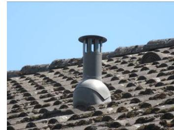
Foto: typische Dachentlüftung
