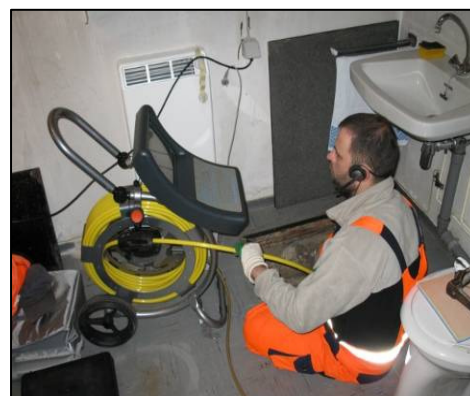
Abb.: Untersuchung mittels geschobener Kanalkamera von einer Revisionsöffnung im Gebäude aus.
