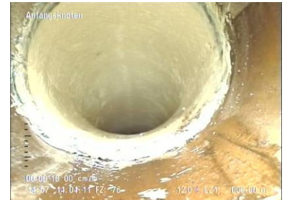
Abb.: verklebter Kurzliner in einem Abwasserrohr
