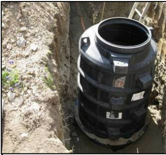
Abb.: Nachrüstung mit einem Kunststoffschacht
