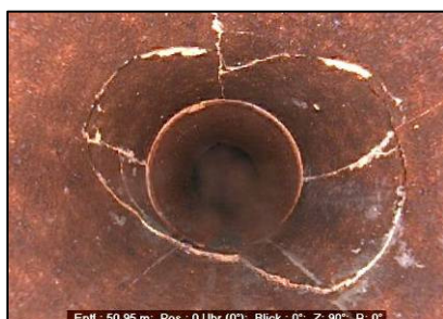
Abb.: Kanalkamerabild einer defekten Leitung (Schervenbildung)
