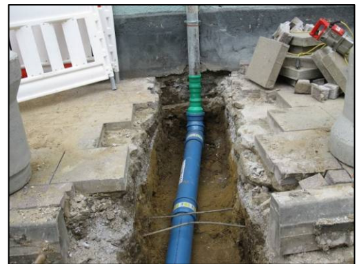
rechts: Erneuerung einer Regenwasserleitung in offener Bauweise
