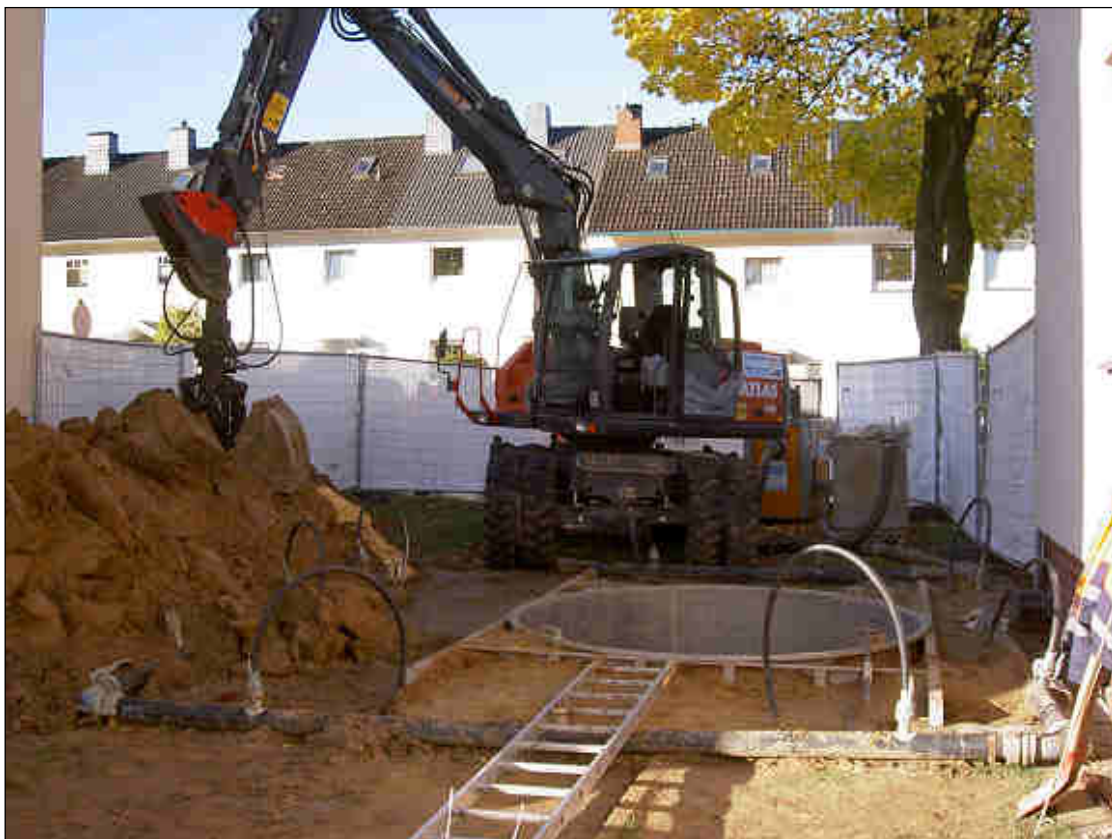
Abbildung 23 Grundwasserhaltung mit Grubenverbau mit Arbeitsfeldsicherung zur Bergung
