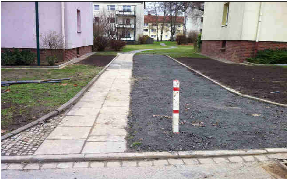
Abbildung 29 Beendete Wiederherstellungsmaßnahme nach erfolgter Entschärfungsmaßnahme
