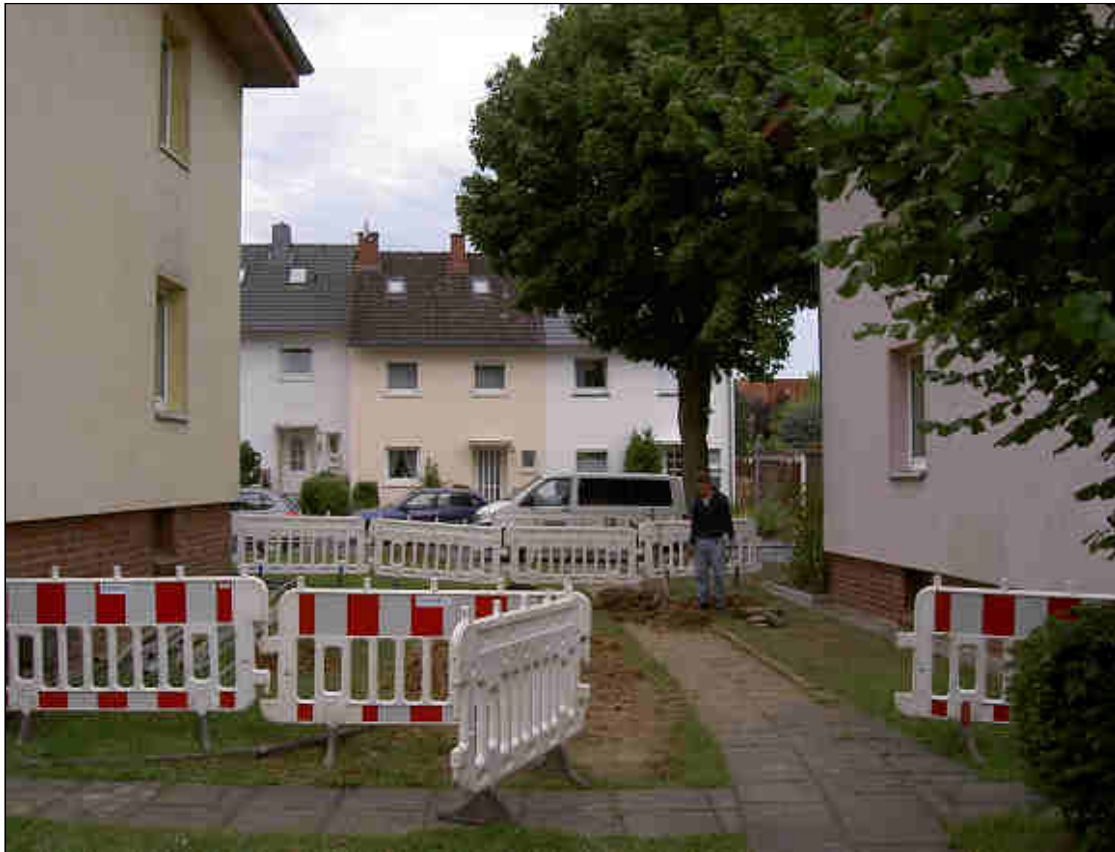
Abbildung 22 Geodätische und fotografische Sicherung der Tiefenortung mit Baustellenabsicherung
