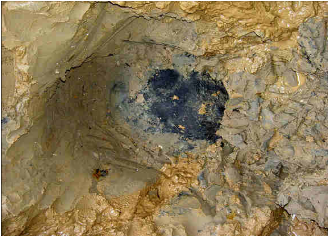
Abbildung 26 Manuelle Freilegung der Ortung und Identifizierung als Sprengbomblindgänger
