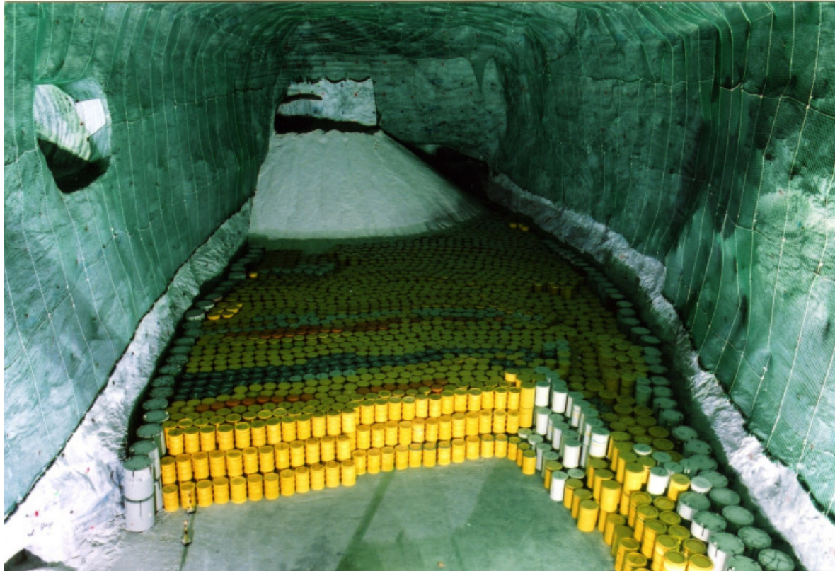
Abbildung 6/70: Hohlraum im Ostfeld des Endlagers (genutzt als Einlagerungskammer mit gestapelten 200-l-Fässern; zu sehen ist die dritte Einlagerungsschicht, darunter befinden sich schon zwei Einlagerungsschichten mit jeweils drei Fässern übereinander und einer Salzzwischenschicht von ca. einem Meter); Quelle: Bundesamt für Strahlenschutz, Endlager Morsleben (2001)
