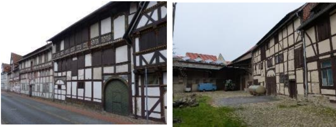
Abb. 15 Straßenfassaden der Gebäude B4 bis A (links) Hofansicht der Gebäude B2 bis B4 (rechts)
