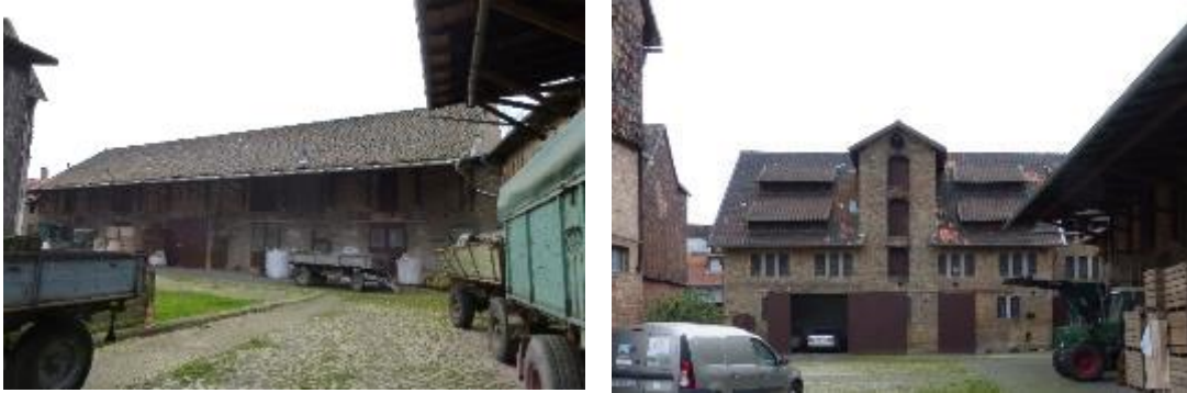
Abb. 16 Stallgebäude D (links) und E (rechts)
