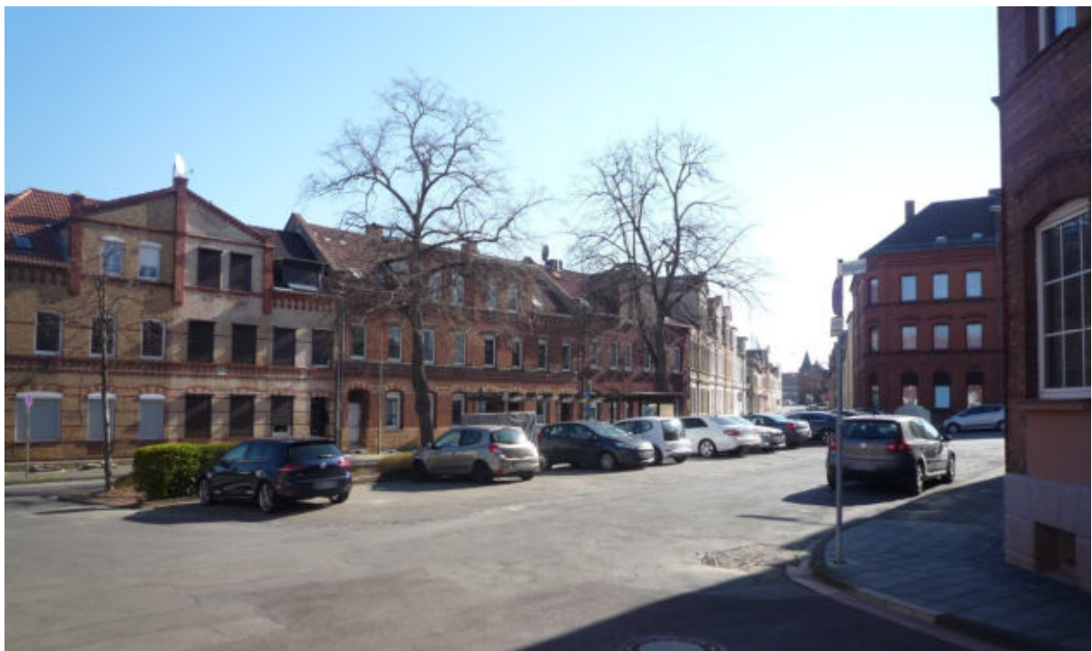
Abb. 20: Conringplatz in aktuellem Zustand
