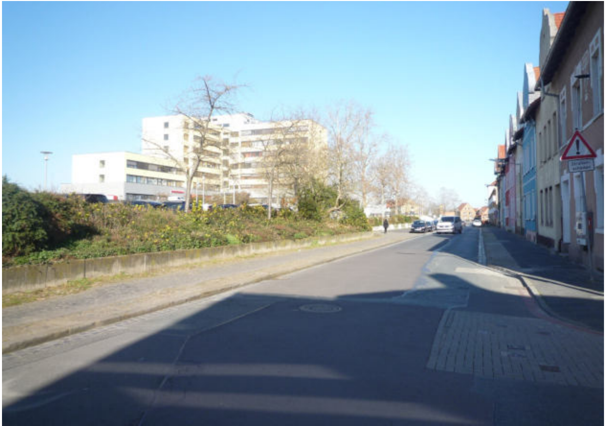
Abb. 32: Conringstraße Richtung Krankenhaus
