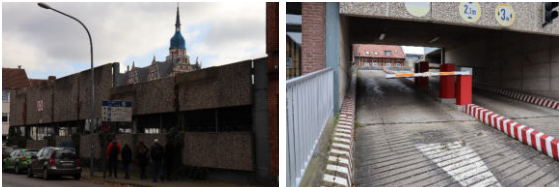
Abb. 24 Parkhaus in der Stobenstraße
