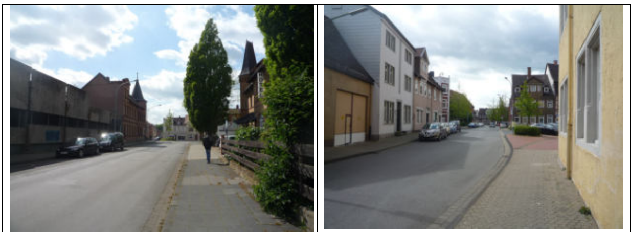
Abb. 59 und 60: Sanierungsbedarf Straßenzüge – Albrechtsstraße und Ziegenmarkt
