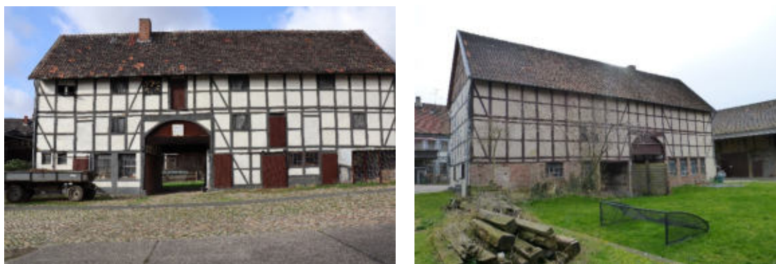
Abb. 13 Gebäude F, Westansicht (links), Ostansicht mit vorgelagerter Grünfläche (rechts)
