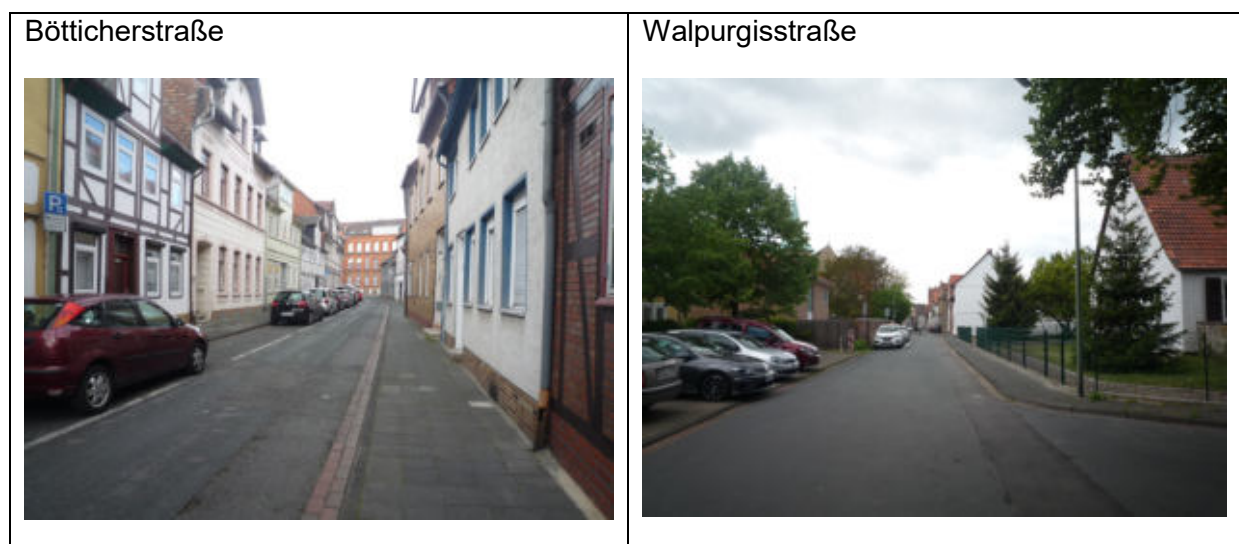
Abb. 57 und 58: Sanierungsbedarf Straßenzüge – Bötticherstraße und Walpurgisstraße
