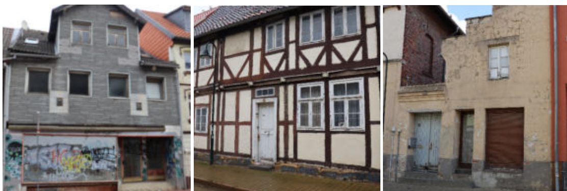
Abb. 7 Gebäude mit Sanierungsbedarf
