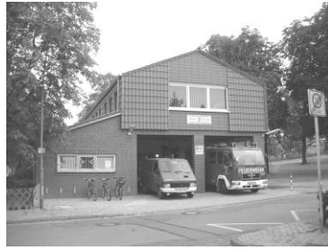
Nach dem Umbau: Schulungsraum Umkleideräume und Sanitäranlagen
