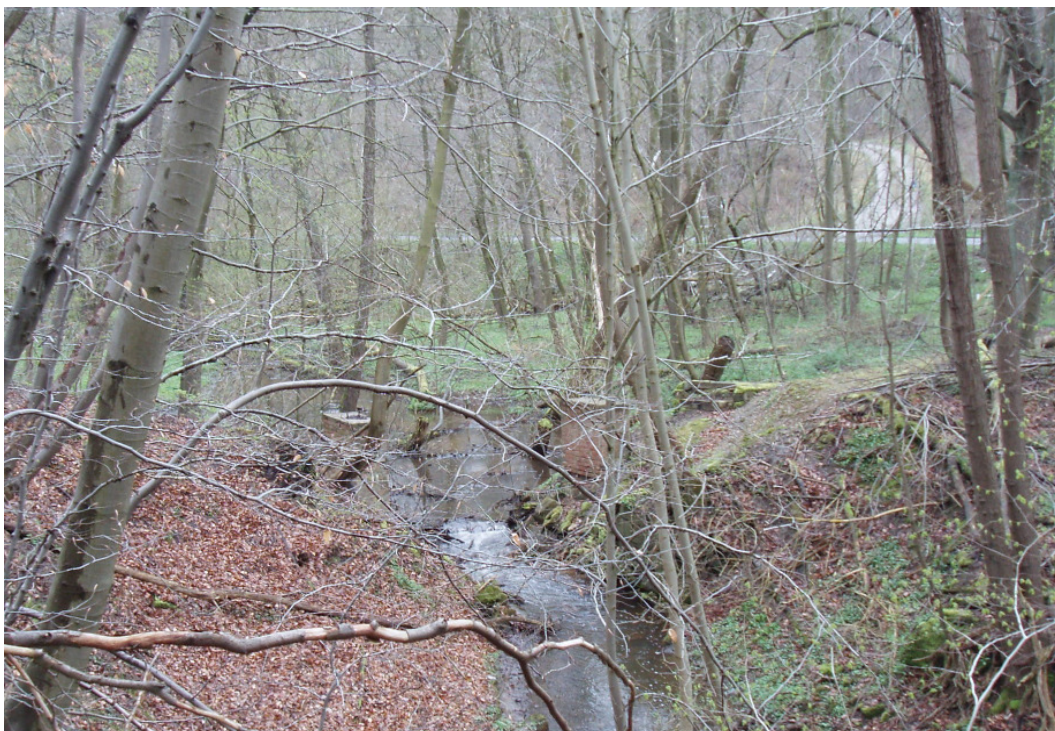
Abb.: Blick von Osten auf den lückig bestockten Auenbereich mit den Brückenpfeilern in der Bildmitte und dem Knüppeldamm nach rechts anschließend (April 2008).
